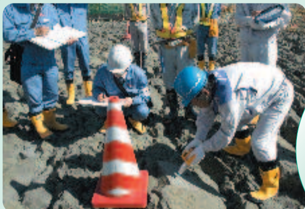
▲「使用前検査」として、原子力発電所の建設現場での岩盤検査も行います。検査員はハンマーで岩を一つ一つ叩いて、浮きの有無を確認します。
