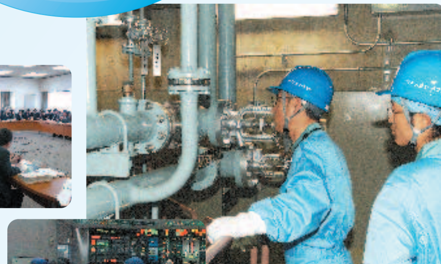
▲原子力保安検査官が、中央制御室や原子力施設を巡視しています。
