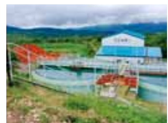
重金属を含む坑廃水の処理
