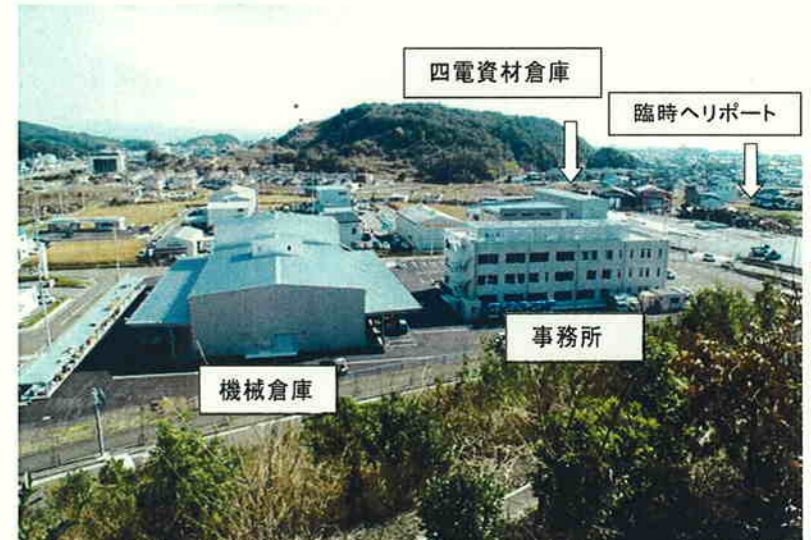
【災害復旧拠点となる関連企業の事務所、機械倉庫】 《高知市長浜産業団地に平成19年2月竣工》 《駐車場は非常用ヘリポートとして使用》 《四国電力の資材倉庫も隣接して整備》
